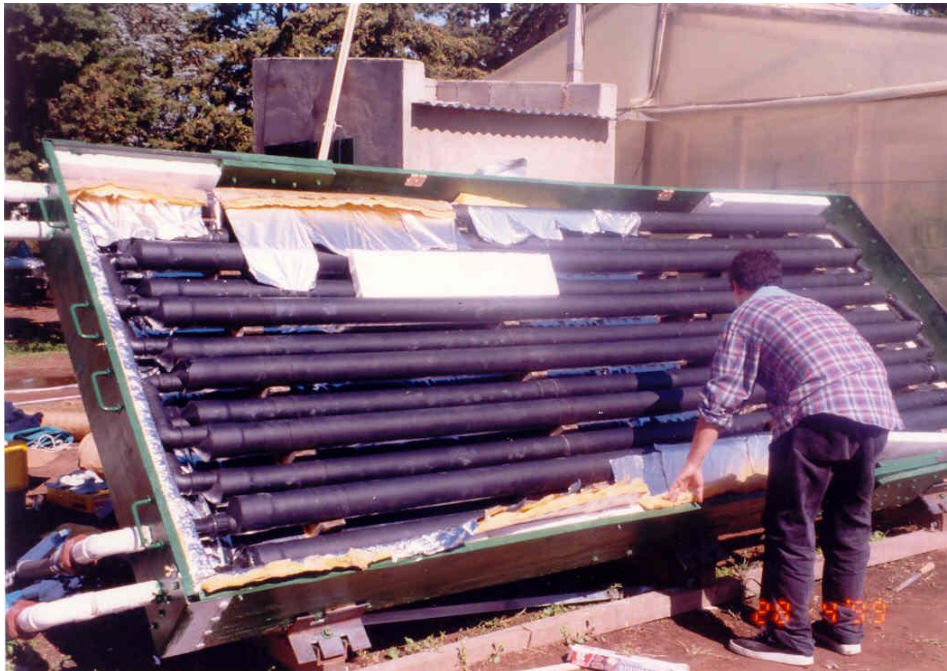
Fig. 4.13. Colocación de aislantes en CAIT UNRC.
