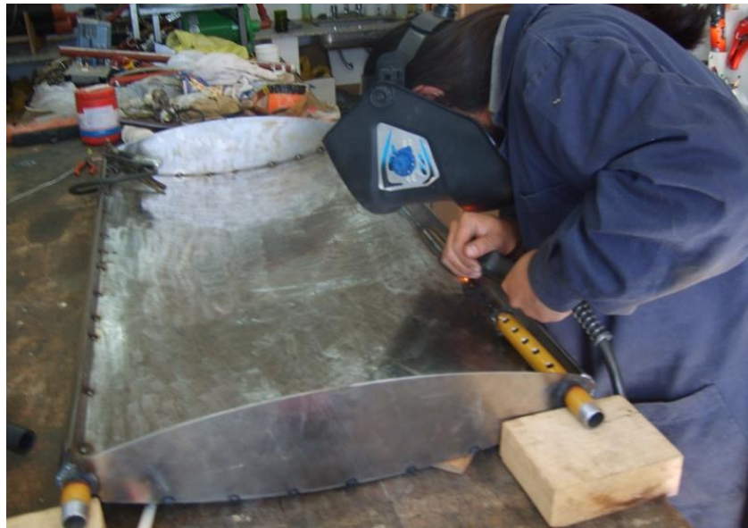
Fig. 7.5. Proceso de fabricación del CAIO. Soldadura del caño perforado para la entrada de agua fría
